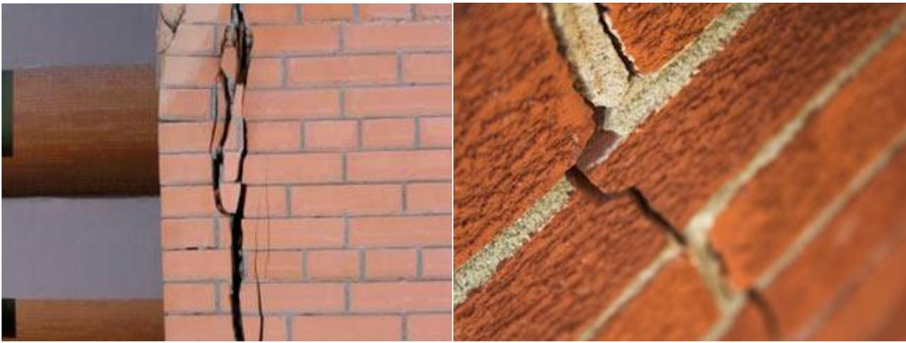
Чтобы этого избежать, в процессе возведения стен в них делают температурные швы – зазоры (шпунты), которые разделяют стены по высоте на отдельные блоки, тем самым придавая зданию некую упругость. Благодаря этой упругости при деформации линейных размеров кладка здания остается целой.
