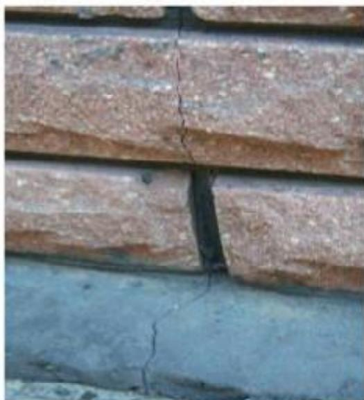
*Причина: толстый слой бетона в фундаменте*
