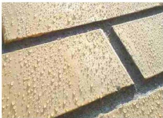
*Эффект обработки гидрофобизатором*
