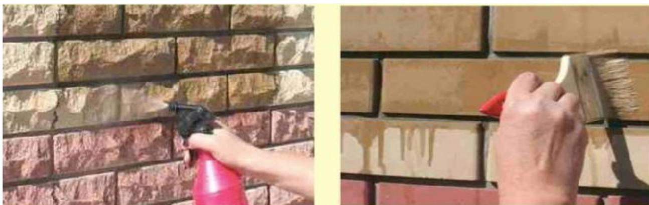
*Нанесения гидрофобизатора распылителем или кистью*
