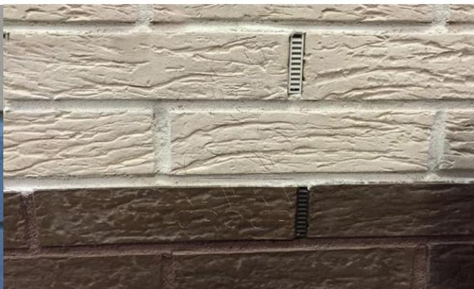
Сейчас появились специальные вентиляционно-осушающие коробочки, которые укладывают вместо пустотного шва. Они предназначены для вентиляции фасадов и отвода конденсата наружу кладки. Благодаря им высушивается внутренняя поверхность фасада, что обеспечивает его долговечность. На вентилируемом фасаде не выступают соляные пятна, не образуется плесень, кроме того,
