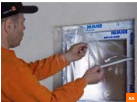
По завершении работ на оконных и дверных проемах снять в месте с планкой защитную пленку.
