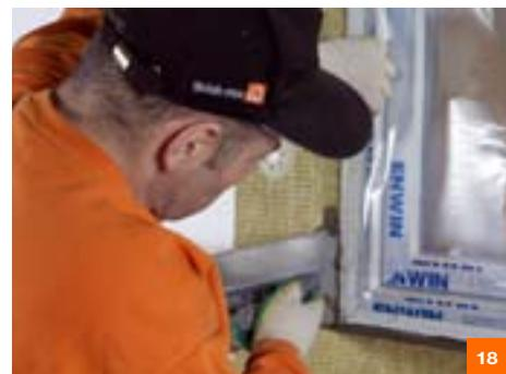
В откосах нанести на торец плит утеплителя приготовленный штукатурный раствор **KAS/SKS** – под сетку профилей примыкания.
