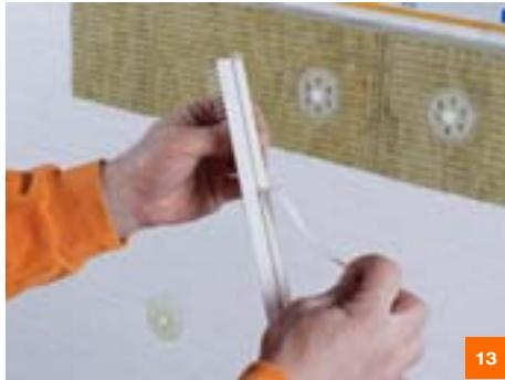
По завершении монтажа утеплителя в откосах на оконные и дверные блоки устанавливаем профиль примыкания **TP-GLU**: 6 мм – на штукатурные участки; 9 мм – на участки с плиткой.
