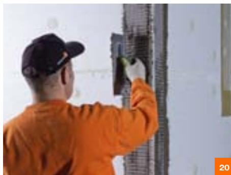
Установить усилитель угла с сеткой на внешних углах здания, приклевив его на приготовленный **KAS/SKS**.
