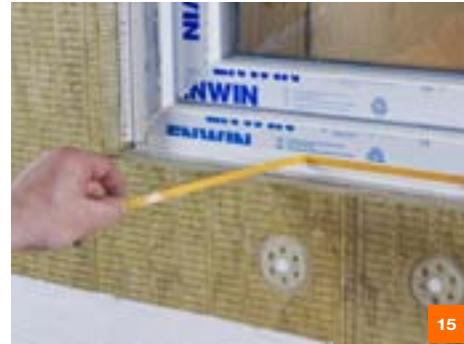
Для защиты оконных и дверных блоков от брызг и наплынов штукатурного раствора снимаем бумажную ленту со скотча планки, на которую устанавливается защитная пленка.
