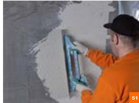
После определения времени схватывания шва «тестом большого пальца» приступают к его расшивке при помощи трубки или расшивки.
