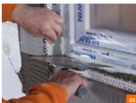
На внутренние углы в проемах ставим косынки из сетки **GWS** размерами 140xT мм, где T – глубина откоса. Излишки раствора снять на «сдир».
