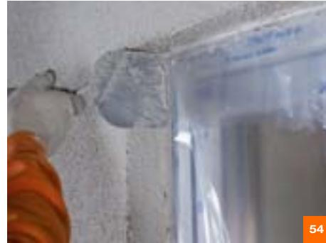
Материал наносится на стену при помощи металлических полуутерков с последующим снятием его «на сдир» и текстурированием круговыми движениями пластиковым полуутерком.
