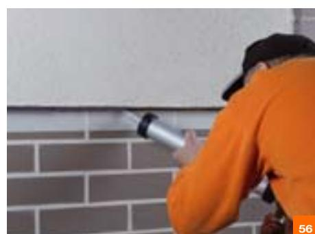
Зазор между отделкой цоколя и стартовым профилем заполнить полиуретановым фасадным уф-стойким герметиком.
