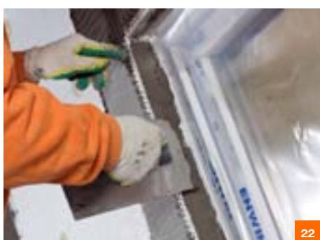
Установить усилитель угла с сеткой на внешние углы проемов, приклевив его на приготовленный **KAS/SKS**.
