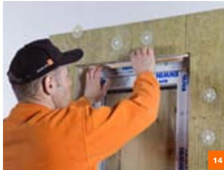
Для этого снимаем защитную пленку с уплотнительной ленты и приклеиваем профиль таким образом, чтобы сетка оказалась на торце утеплителя.
