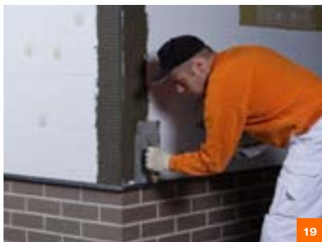
Нанести базовый штукатурный раствор **KAS/SKS** на места установки профилей угловых **TP-GE150** с сеткой 10x15 мм.
