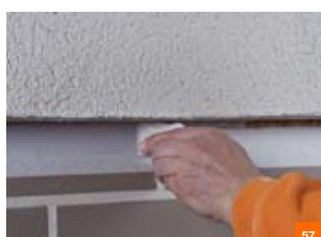
Снимаем излишки герметика резиновым шпателем.
